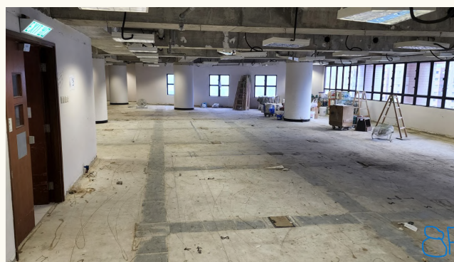
▲正在進行翻新工程的8樓。
